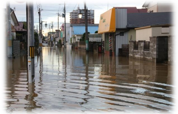
市内のいたるところで道路が冠水しました
