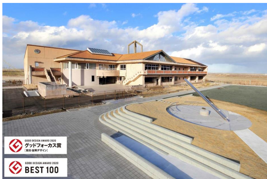
震災遺構中浜小学校（山元町）
