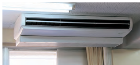
▲設置されたエアコン (西中)
