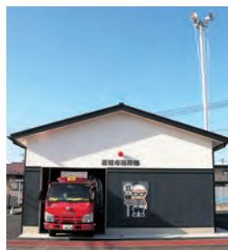
▲消防団千貫分団機動部ポンプ置き場
