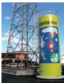
▲緊急用飲料水備蓄タンク
