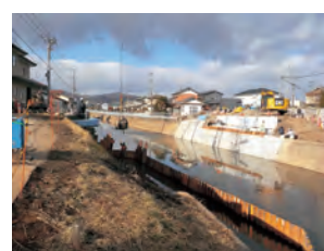
▲工事中の岩沼橋
