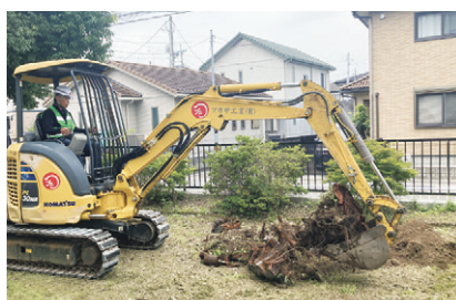
▲伐根作業 (岩沼小学校)
