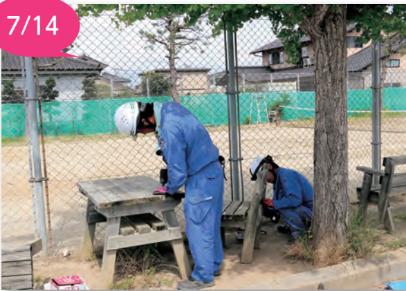
▲ベンチの補修作業（北中）
