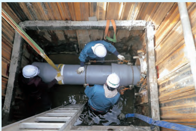
▲水道管工事の様子
