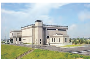
▲押分排水機場
