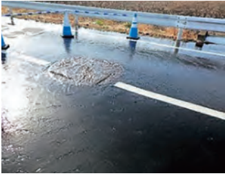
▲南長谷の漏水
