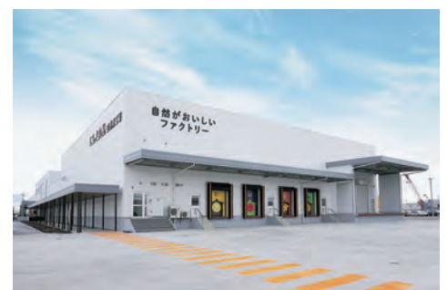
▲令和2年に稼働した空港南工場
