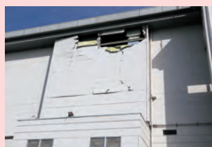
▲総合体育館の崩れ落ちた壁
