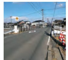
▶工事する岩沼橋
