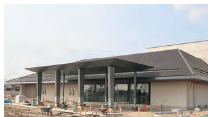
▲駐車場は、利用者用41台、バス用3台となっています
