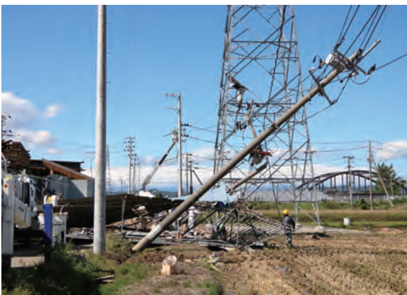
▲下野郷では電柱が倒れるなどの被害が発生しました
