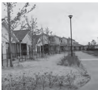
▲被災された方々が新たな生活をスタートさせている集団移転先、玉浦西部地区
