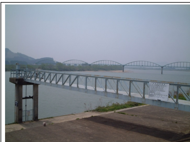
図 2-8 玉崎浄水場の取水口
