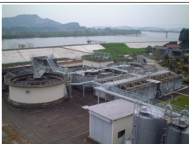
図 2-9 玉崎浄水場の全景
