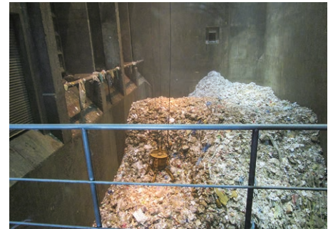
岩沼東部環境センターのごみピット
