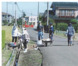
(写真：側溝清掃の様子)
