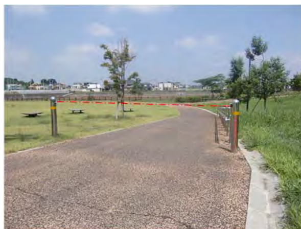
洪水警告表示ポール(ここより下は水に浸かる)
