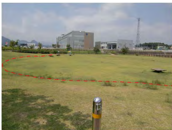
公園兼調整池の事例：赤線内側が通常時は公園で大雨の時に水に浸かる部分(大和町まほろば公園)
