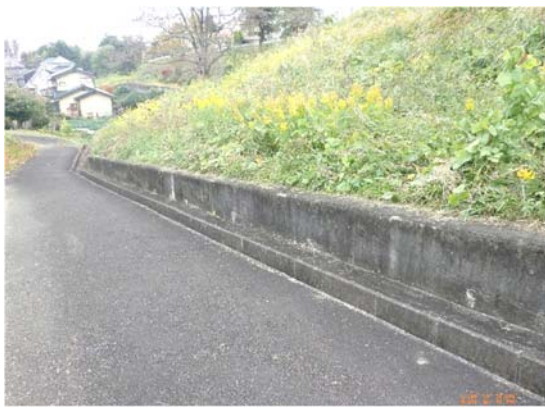
写真11 土留め擁壁・側溝(変状無し)
