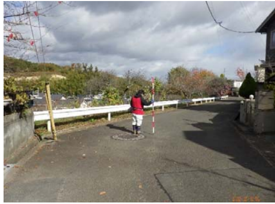
写真1 盛土上舗装(変状無し)
