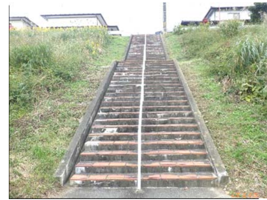
写真13 盛土内階段(変状無し)
