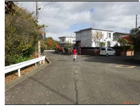
写真3 盛土上舗装(変状無し)
