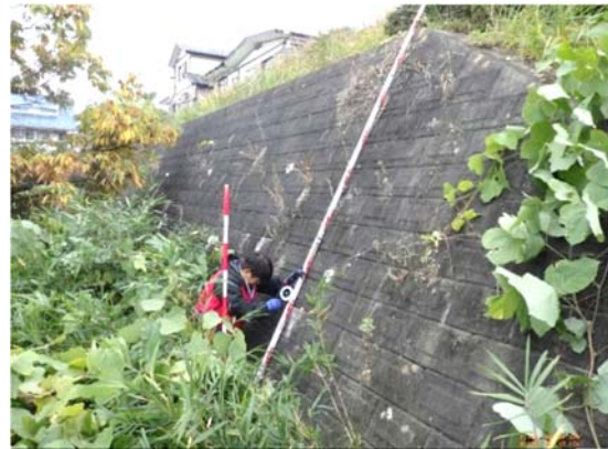
写真4 擁壁状況(H=3.9m)
