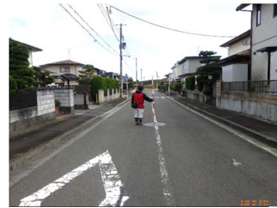
写真3 盛土上舗装(変状無し)
