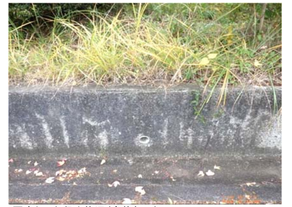
写真3 土留め状況(変状無し)
