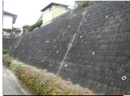
写真7 擁壁状況(変状無し)
