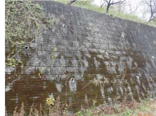
写真6 末端擁壁(変状無し)
