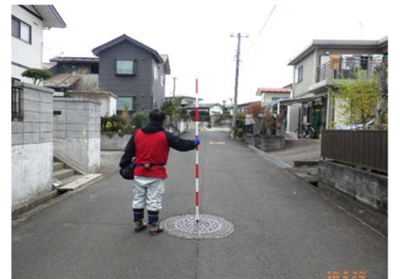
写真13 盛土上舗装(変状無し)
