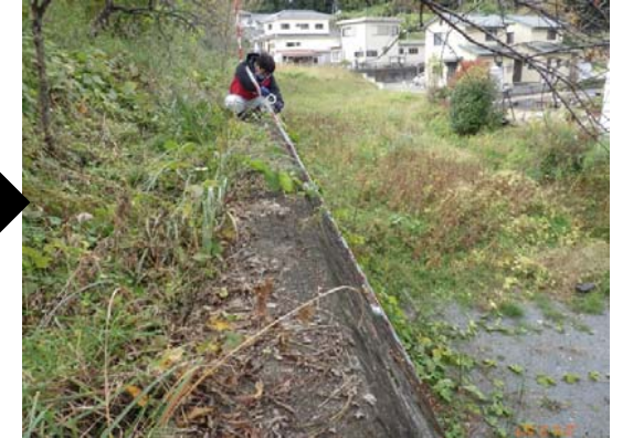
写真7 末端擁壁(練積みH=4.4m程度)
