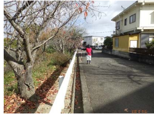
写真2 盛土上舗装(変状無し)
