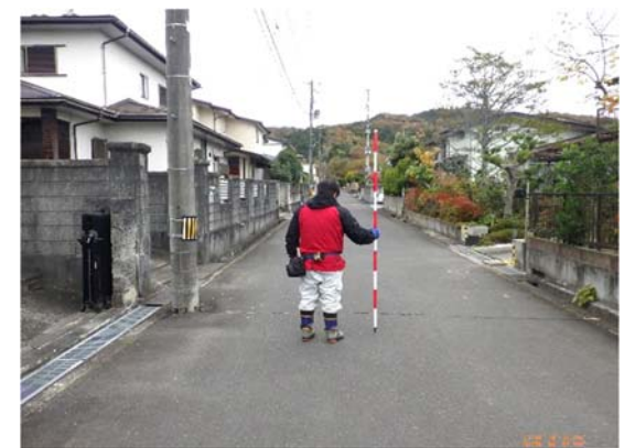
写真8 盛土上舗装(変状無し)
