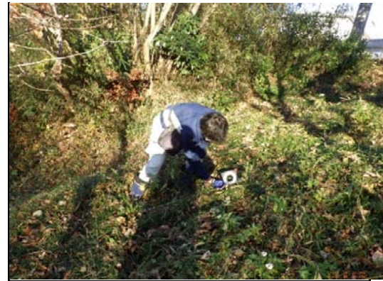
写真5 末端法面(変状無し)
