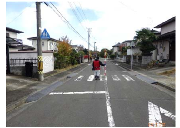
写真4 盛土上舗装(変状無し)
