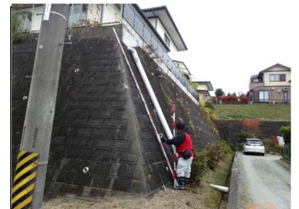
写真6 擁壁状況(H=4.8m)
