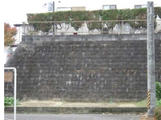
写真8 擁壁状況(変状無し)
