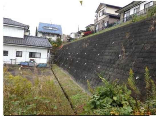
写真5 擁壁状況(変状無し)
