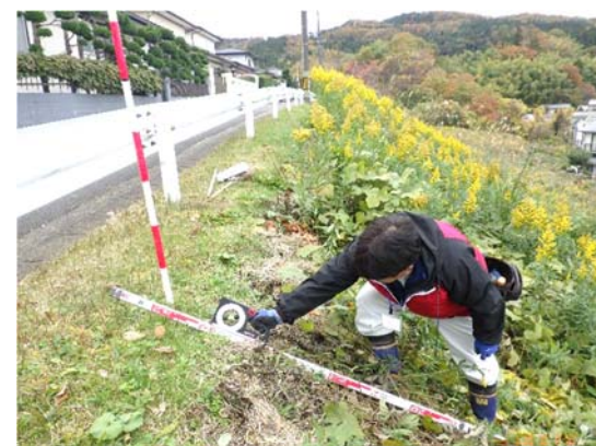
写真10 法面状況(変状無し)
