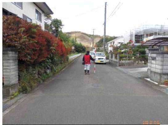
写真5 盛土上舗装(変状無し)
