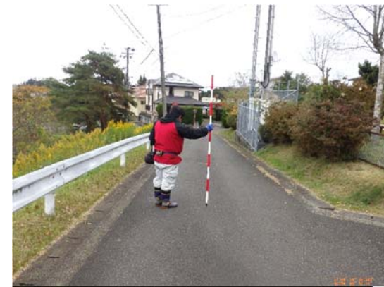
写真7 盛土上舗装(変状無し)
