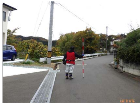
写真10 盛土上舗装(変状無し)
