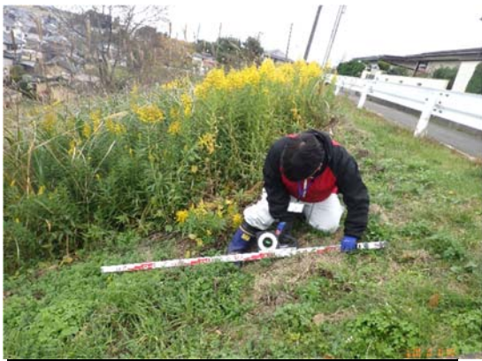
写真9 法面状況(変状無し)
