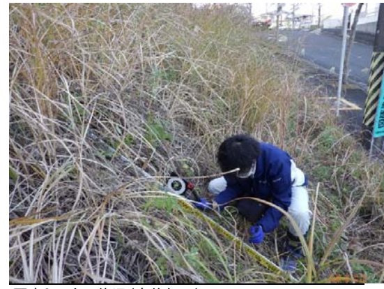
写真2 法面状況(変状無し)
