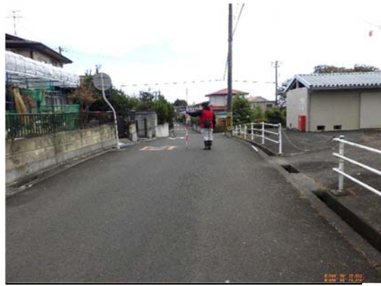
写真1 盛土上舗装(変状無し)
