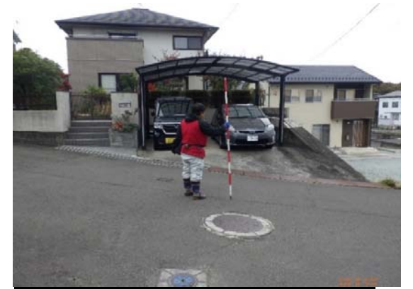
写真9 盛土上舗装(変状無し)
