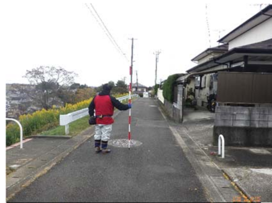
写真6 盛土上舗装(変状無し)
