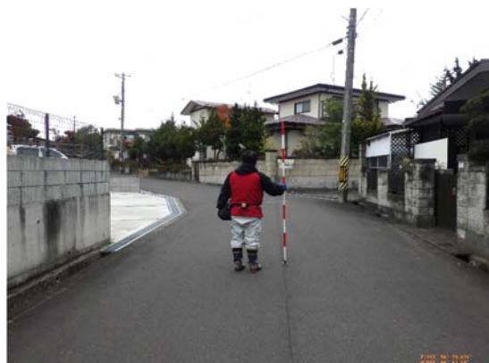
写真12 盛土上舗装(変状無し)
