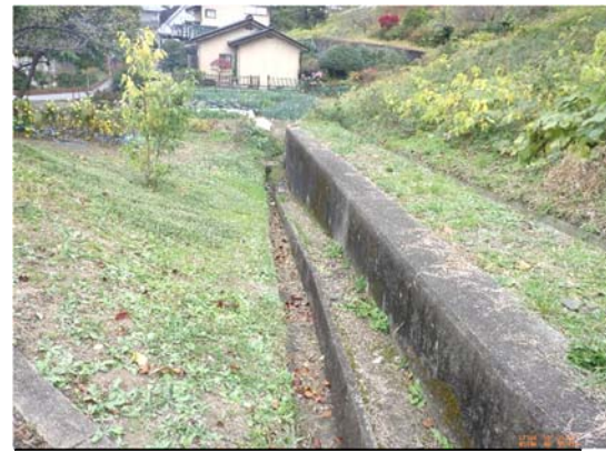
写真12 土留め擁壁・側溝(変状無し)
