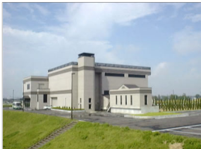
押分排水機場(ポンプ場)
