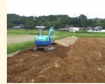
土層改良（客土）
