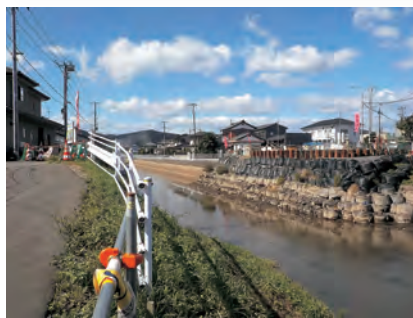
▲現在工事中の岩沼橋
