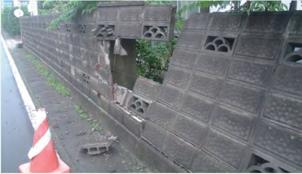
▲宮城県北部連続地震により倒壊したブロック塀 (2003年)
