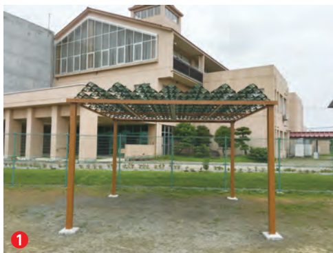
▲校庭に設置された鋼板製の日よけ
