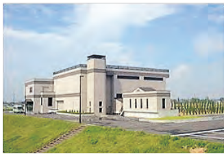
▲押分排水機場
