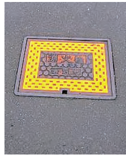
▲消火栓蓋 （丸型の蓋もあります）
