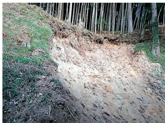
▲整備をしていない森林が崩れてしまった様子
