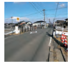
▶工事する岩沼橋
