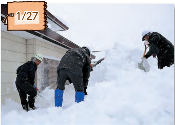
▲積雪量が2メートルを超える中、作業する様子
