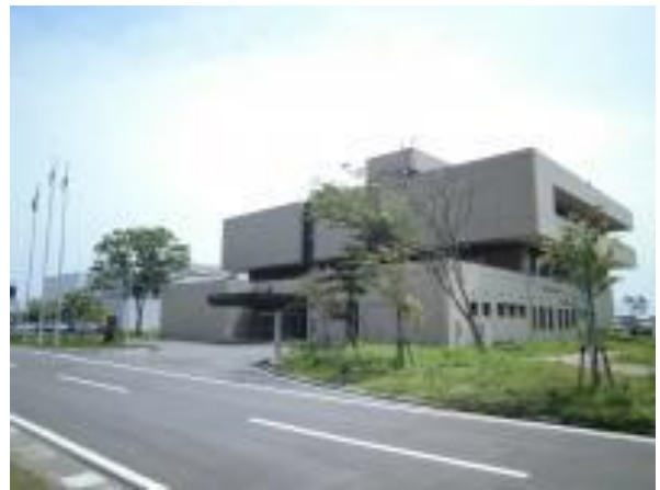
図 2-3 県南浄化センター
