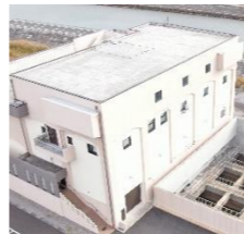
矢野目排水ポンプ場
