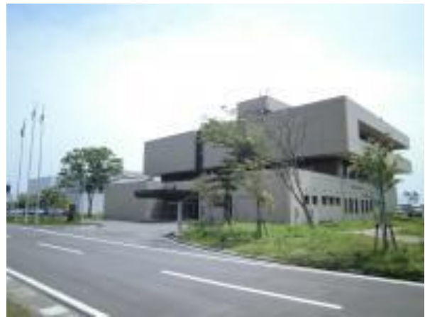
図 2-3 県南浄化センター
