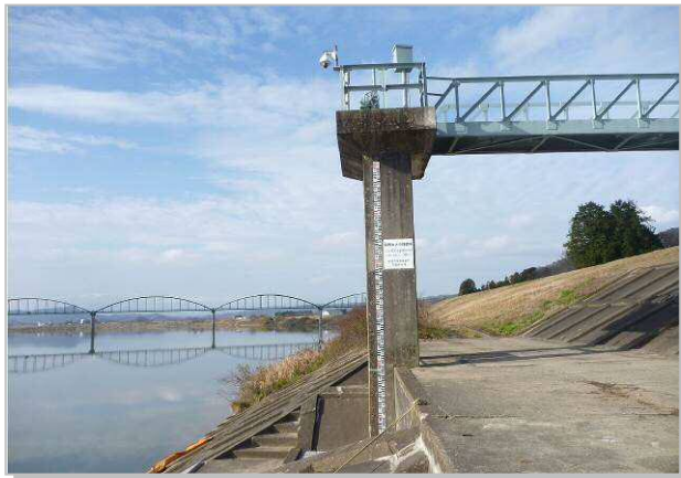
玉崎浄水場取水門 (阿武隈川表流水)
