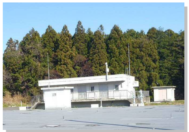
受水池 (仙南・仙塩広域水道と自己水の受水池)
