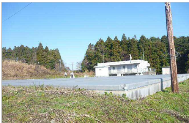
根方高区配水池
