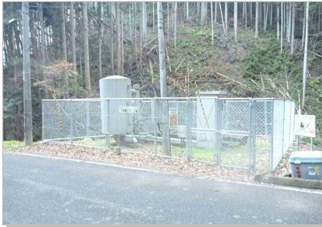
志賀第二ポンプ場
