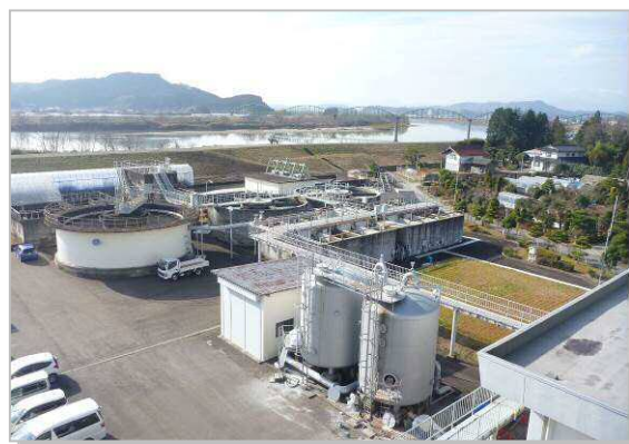
玉崎浄水場全景
