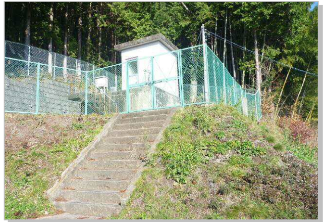
志賀第二配水池
